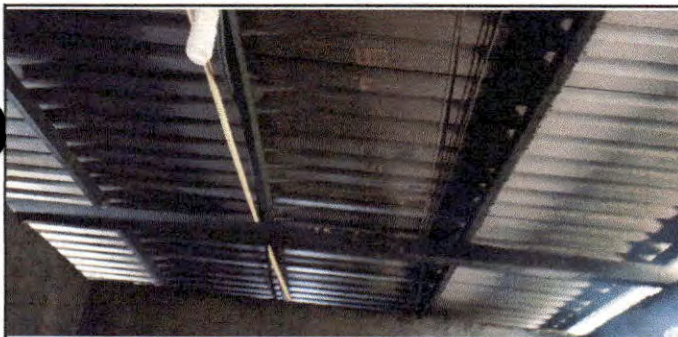
Foto 11: lamina con filtraciones y agujeros.
