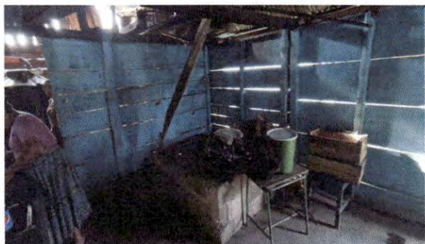
Foto 3: Muro portante de madera
