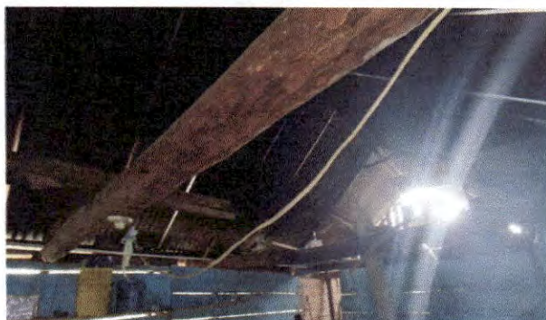
Foto 4: parte de estructura de techo de madera
